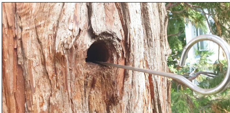
Sondierstab im Einsatz
